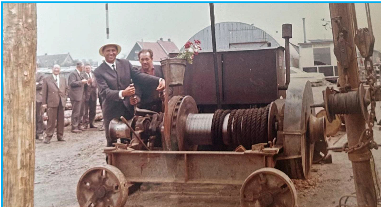
Richnel Mimiasie (met helm) slaat eerste paal voor nieuw bedrijfsgebouw, ca. 1965
